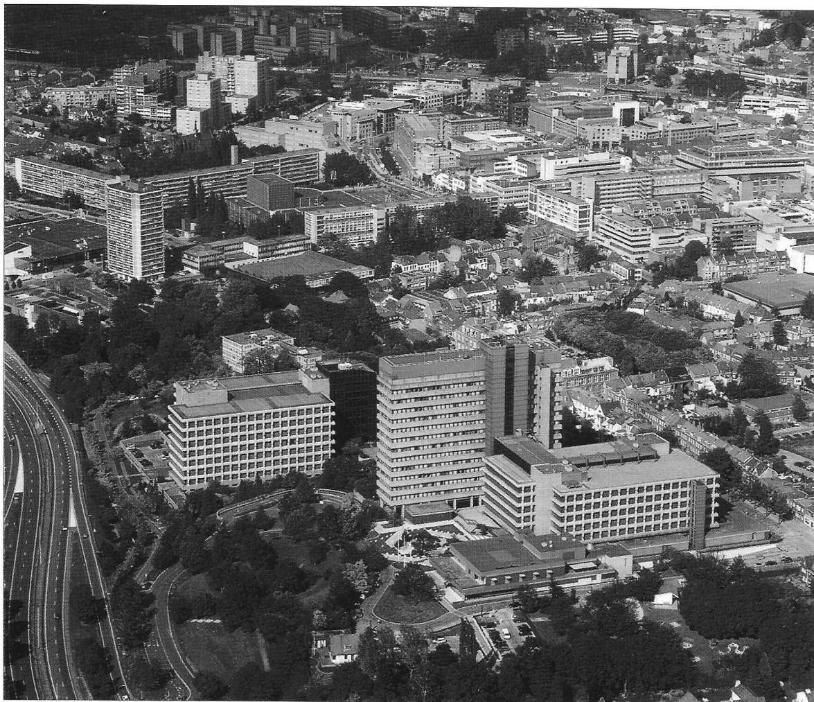
Op de voorgrond het ABP-complex te Heerlen
